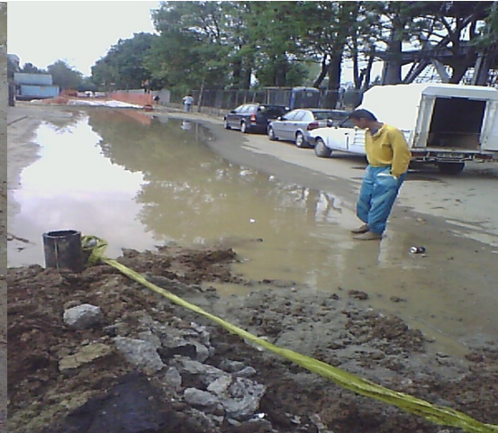
Fig. 6- Apă staționată pe stradă
