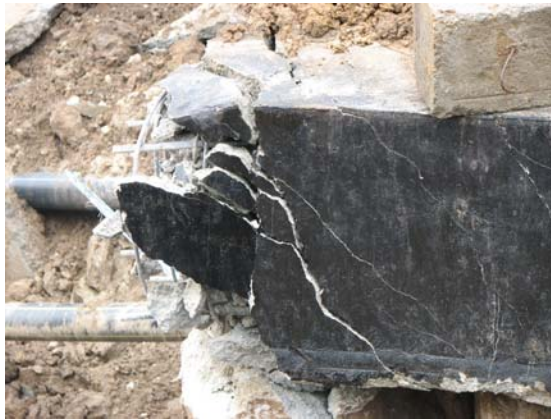
Fig. 9-Armături smulse din grinda de coronament
